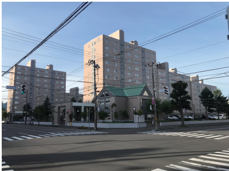
ラポール桑園駅前住宅 第2回大規模修繕工事
