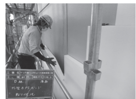
外断熱改修工事(外壁)
