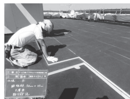
外断熱改修工事(屋上)
