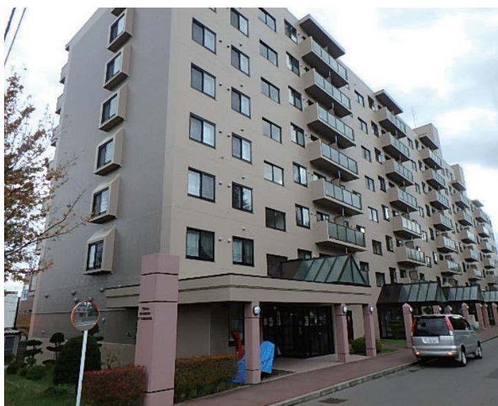
トータルマンション北野通り 大規模修繕工事
