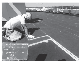
外断熱改修工事(屋上)
