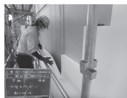
外断熱改修工事(外壁)
