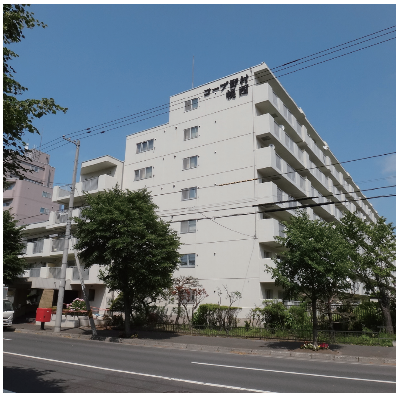
工事名/コープ野村幌西大規模修繕工事
