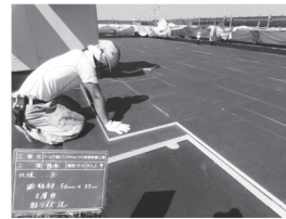
外断熱化工事(屋上)
