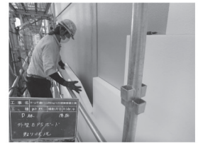
外断熱化工事(外壁)
