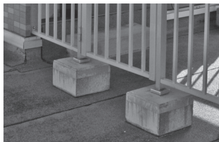
(2) 撤去復旧が容易な場合。人力により移動可 フェンス基礎ブロック
