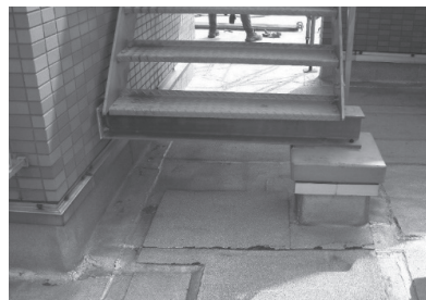
(3) 解体改修後何らかの復旧を要する場合 ⇒ 階段鉄骨切詰め基礎改修 (改修前)
