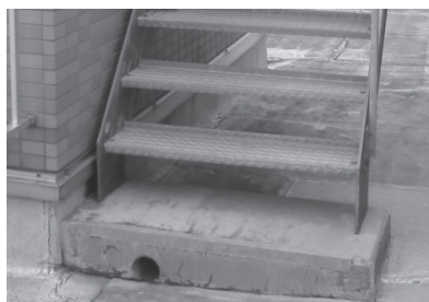
(3) 解体改修後何らかの復旧を要する場合 ⇒ 階段鉄骨切詰め基礎改修 (改修前)
